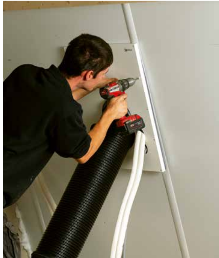
Celdex realiseerde een meervoudig dakdoorvoer manchet op maat voor de installaties.
