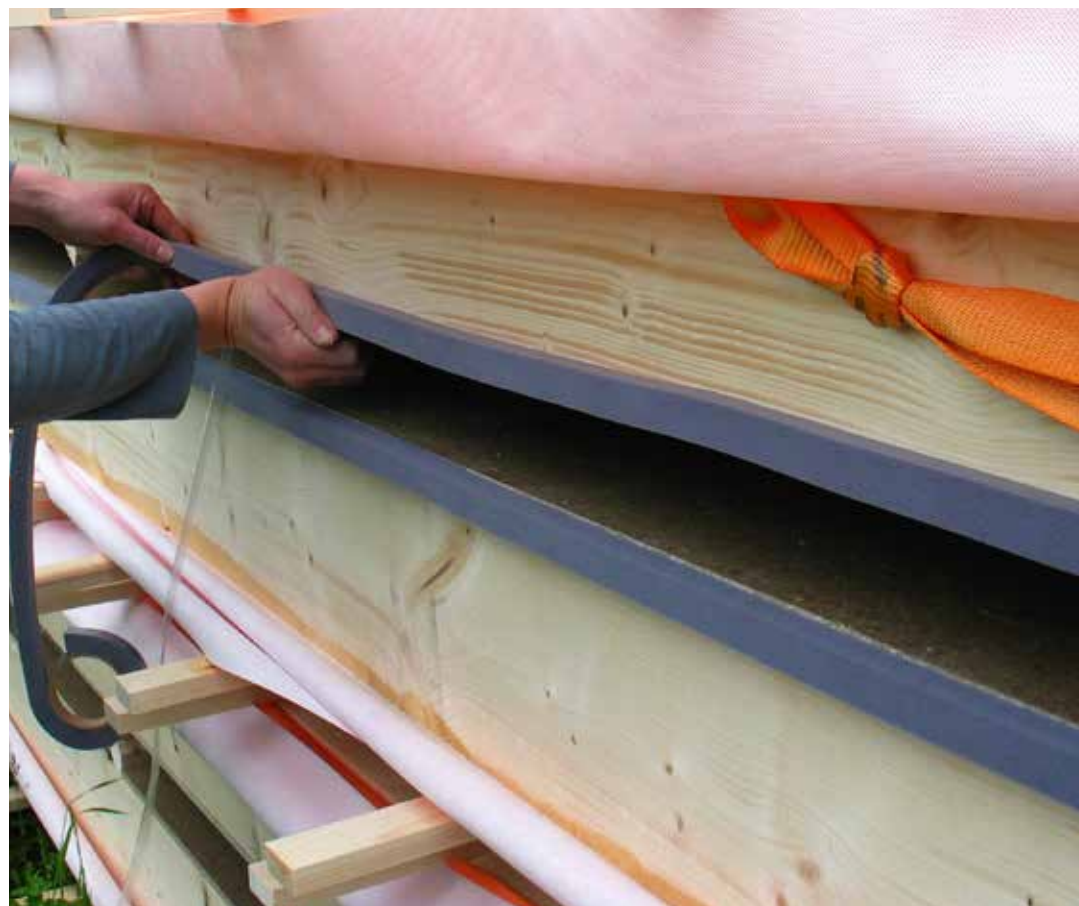
Aanbrengen van de Celdex Pre-Seal op een HSB dakelement.
