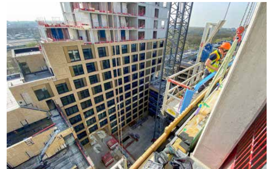
Montage van de elementen.
