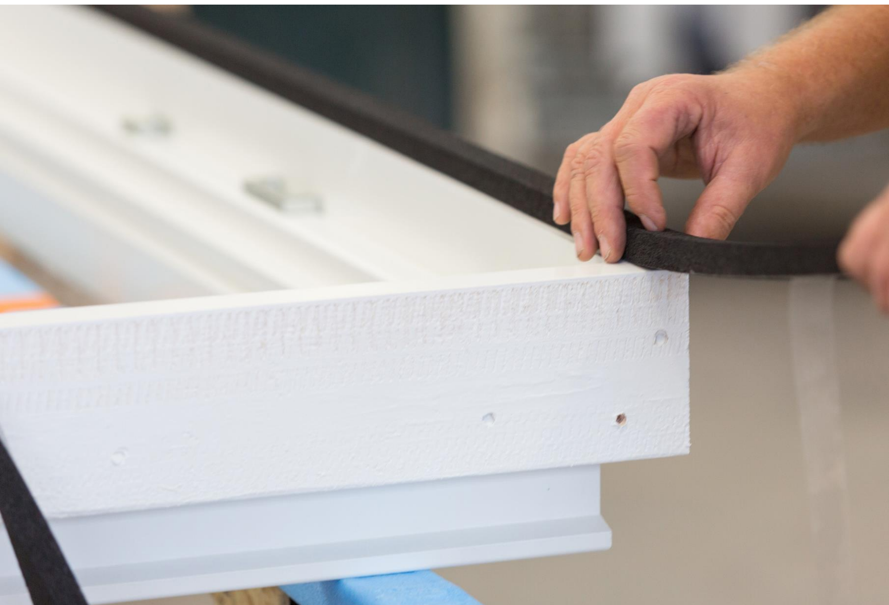
Toepassing van de Celdex EPDM Stelkozijnband.
