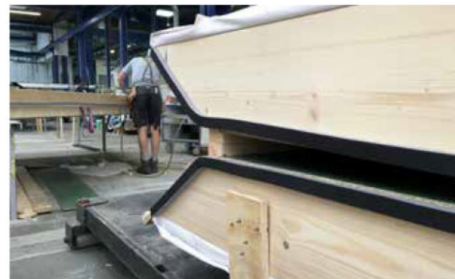
Renovatie - Celdex Pre-Seal LF voor HSB dakelementen.
